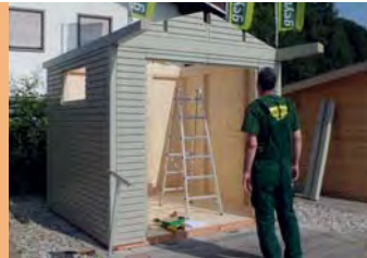
Einsetzen der fertig montierten Wand- und Giebelelemente
