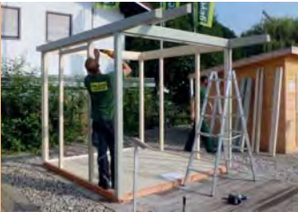
Aufbau der Skelettstruktur
