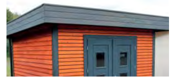
Flachdach (mit Dachüberstand)
