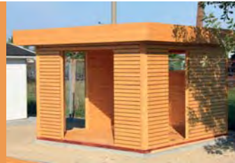
Dach- und Wandschalung
