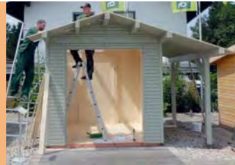
Erstellung der Dachschalung
