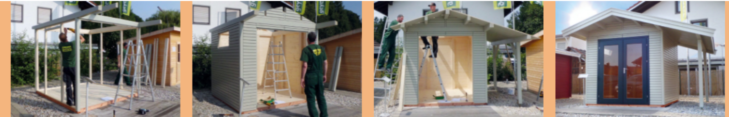
Aufbau der Skelettstruktur
