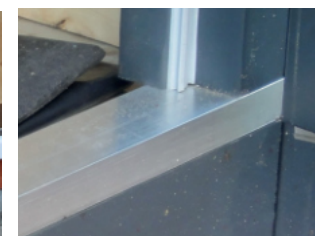
Türschwellen mit Edelstahlabdeckung oder mit Aluschwelle optional möglich
