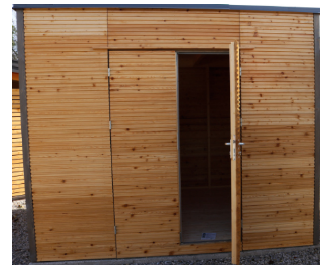
Bündiger Verlauf mit der Wand nur bei geschlossenen Türen möglich.
