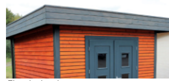
Flachdach (mit Dachüberstand)
