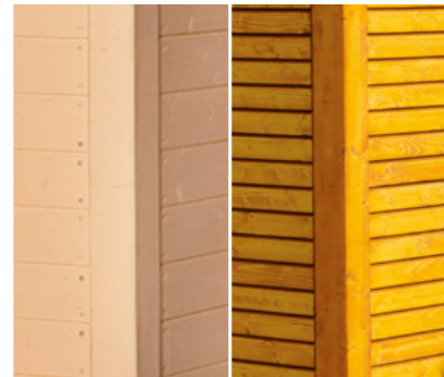
28/45 mm Blockbohle Rhombusschalung
